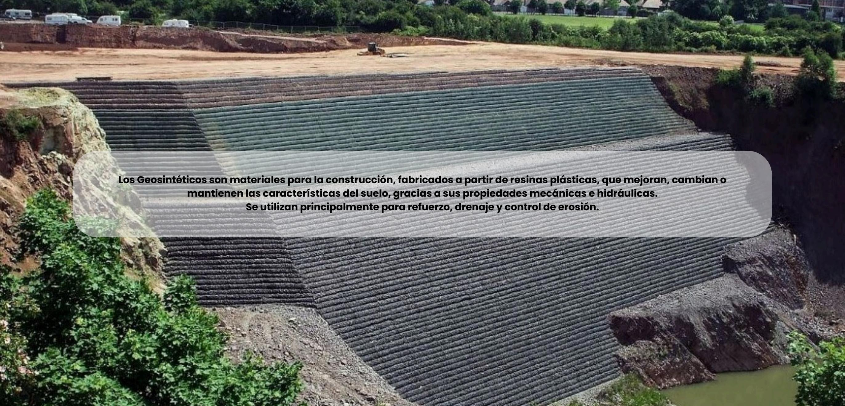
**Los Geosintéticos son materiales para la construcción, fabricados a partir de resinas plásticas, que mejoran, cambian o mantienen las características del suelo, gracias a sus propiedades mecánicas e hidráulicas. Se utilizan principalmente para refuerzo, drenaje y control de erosión.**
