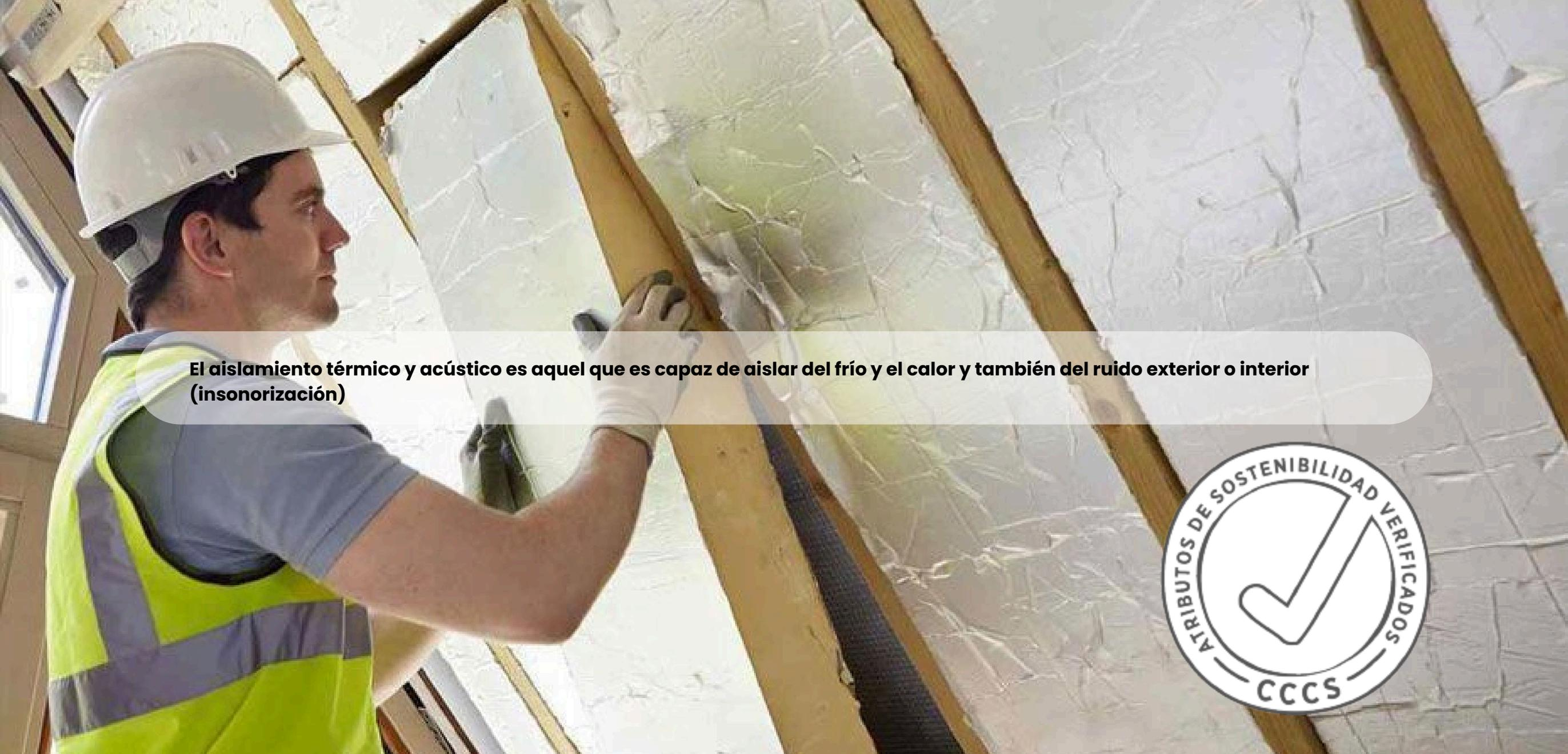
**El aislamiento térmico y acústico es aquel que es capaz de aislar del frío y el calor y también del ruido exterior o interior (insonorización)**
