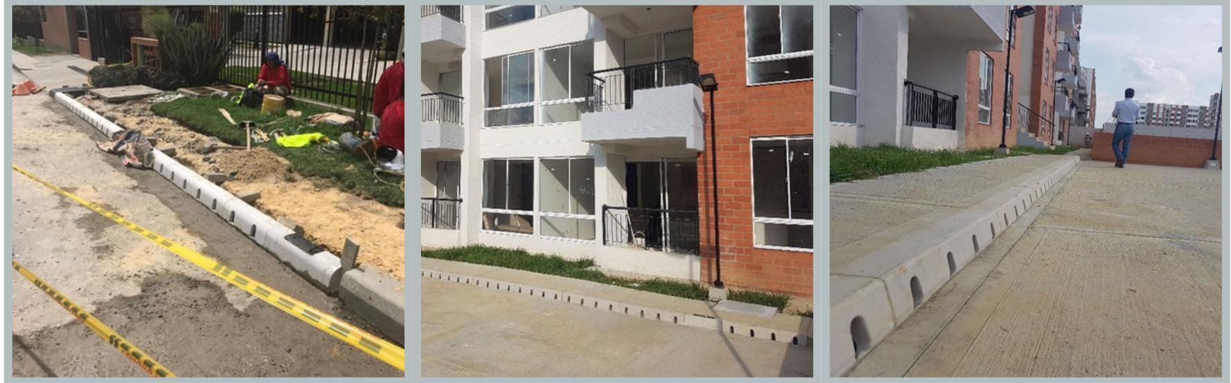
canales de anchos interiores 100, 150 y 250 para clases de carga A15 y B125. Con cuerpos de nuevo diseño y gran variedad de acabado de rejas, los canales SELF de ACO suponen una gama básica, versátil y de gran calidad con la que poder dar solución a gran variedad de necesidades de drenaje de aguas pluviales
